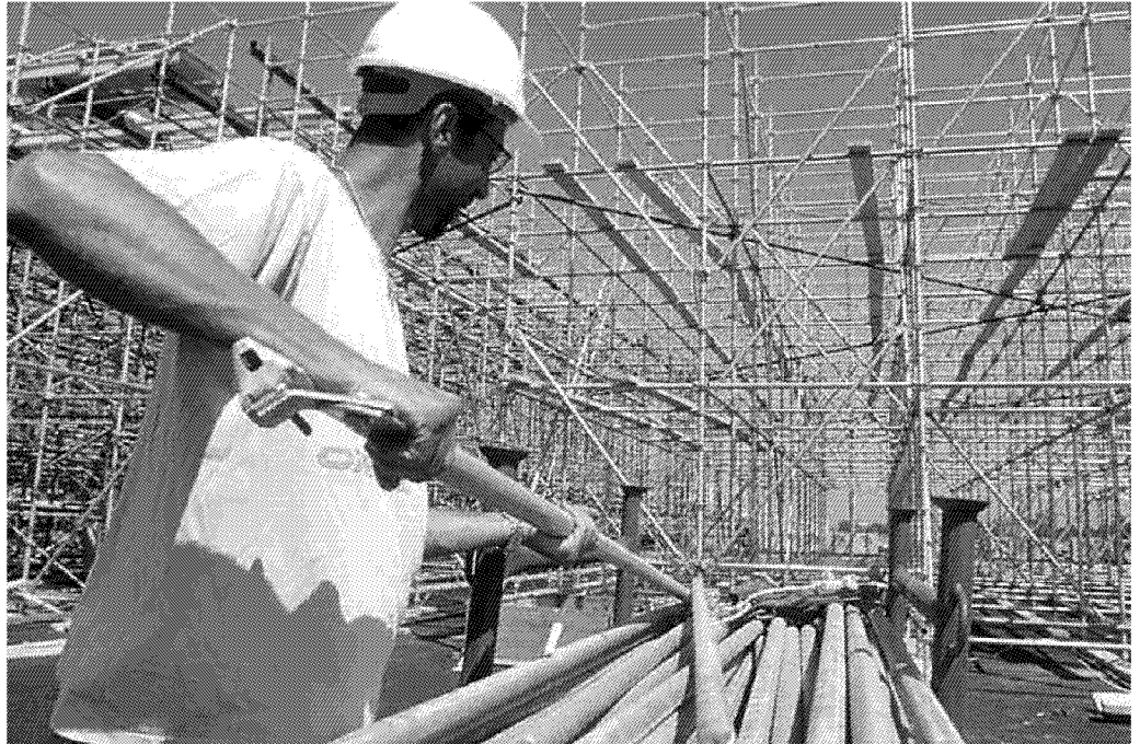
Un operaio al lavoro in un cantiere
